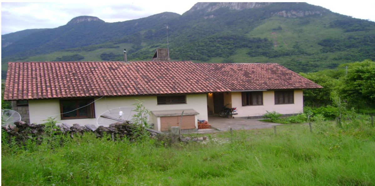
Foto 32. Vista dos Fundos do posto de Fiscalização do ICMBIO (IBAMA), construído no território quilombola, em frente à casa de uma das famílias remanescentes. (SILVA, et al, 2008, p. 88).
