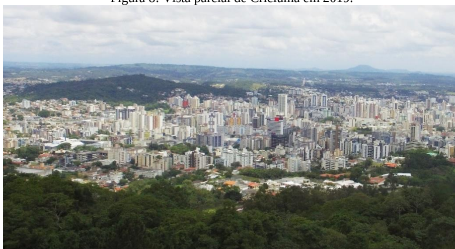
Figura 8: Vista parcial de Criciúma em 2019.
