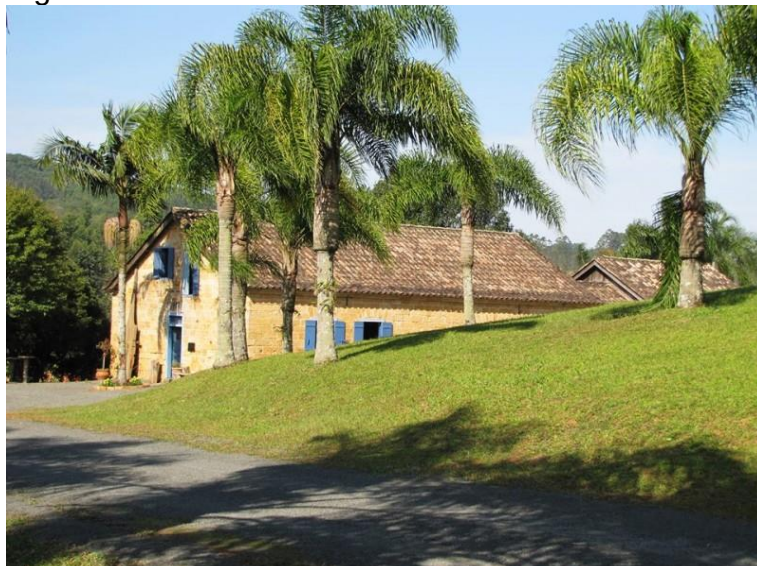
Figura 5 - Casa de Pedra
