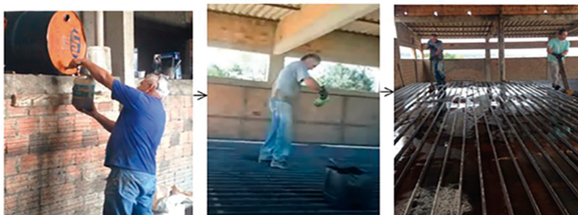
Figura 4 – Processo de lubrificação da forma
