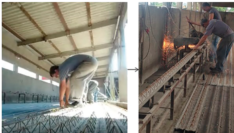
Figura 8 – Processo de deformar e cortar vigas
