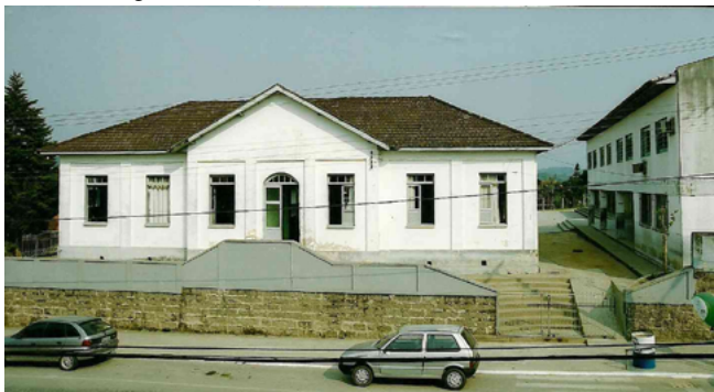
Figura 3 - Antigas instalações da escola: (2002) - EEB Costa Carneiro
