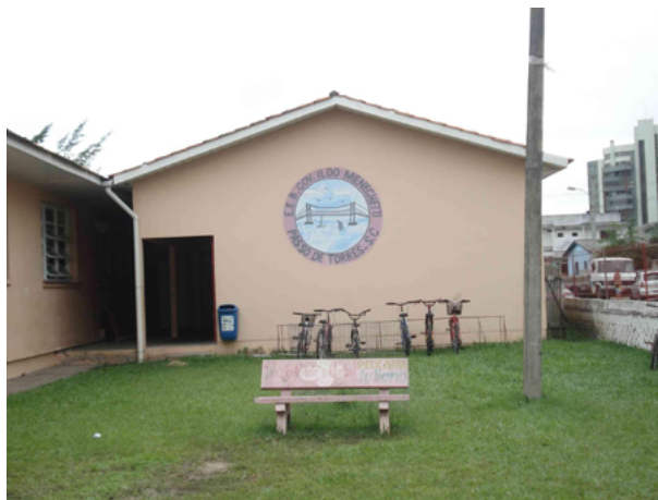
Figura 3 - Instalações e do pátio da escola (déc. 2000) - EEB Ildo Meneghetti
