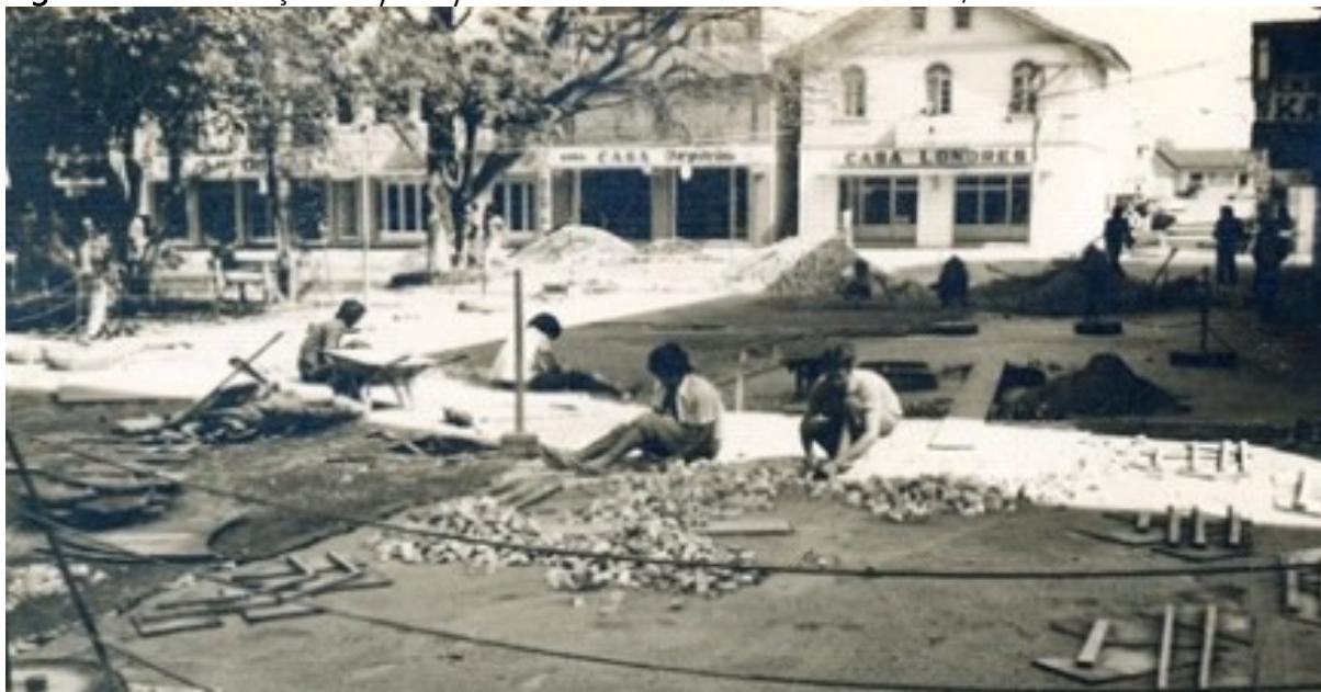
Figura 26 – Colocação do petit pavet em frente à Catedral São José, em 1977
