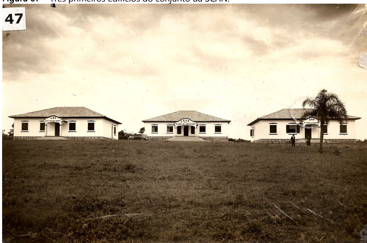
Figura 67 – Três primeiros edifícios do conjunto da SCAN.
