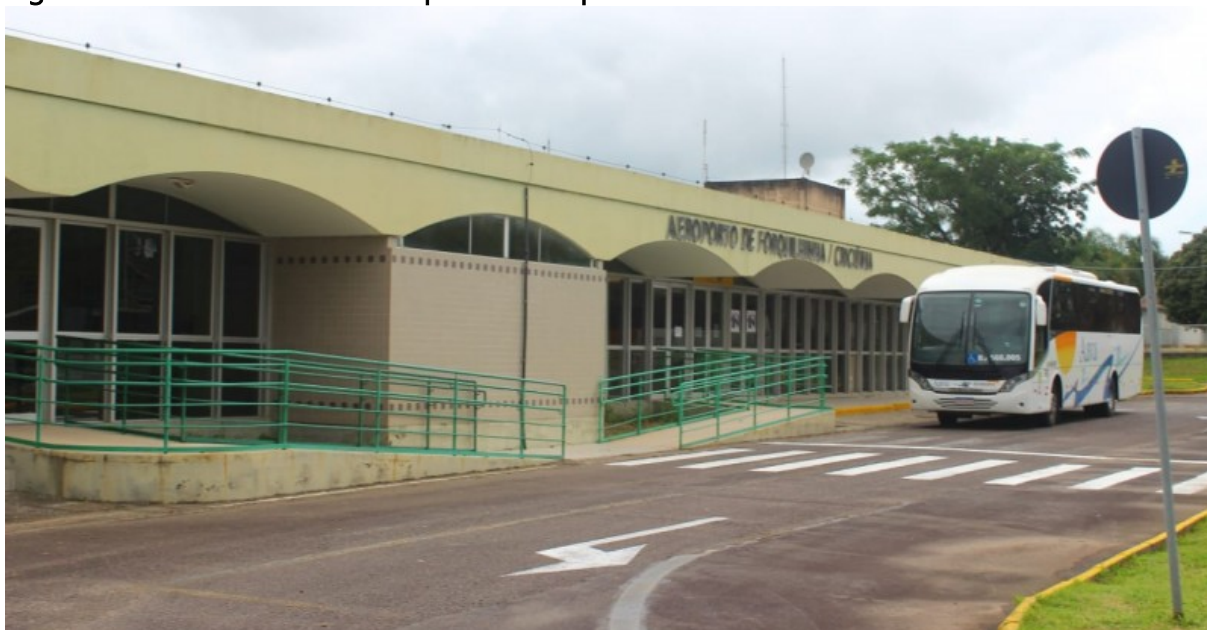
Figura 84 – Terminal de Embarque do Aeropor Diomício Freitas
