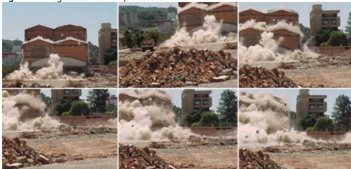
Figura 54 – Registros da demolição da CESACA
