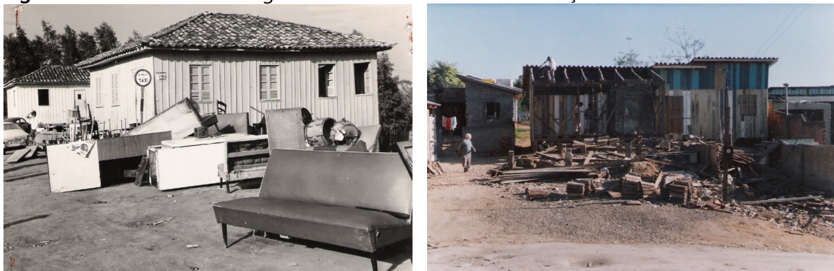
Figura 51 - Casa da Maracangalha em 1972 e início das demolições em 2004
