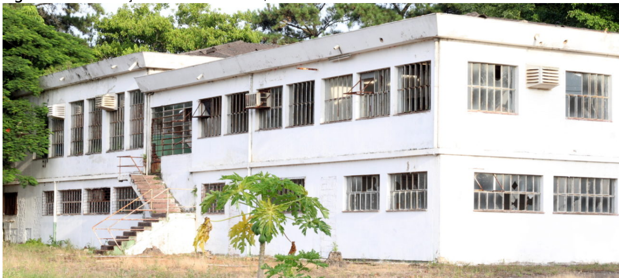
Figura 16 – Edificação da CSN em 2022, antes de ser demolida.
