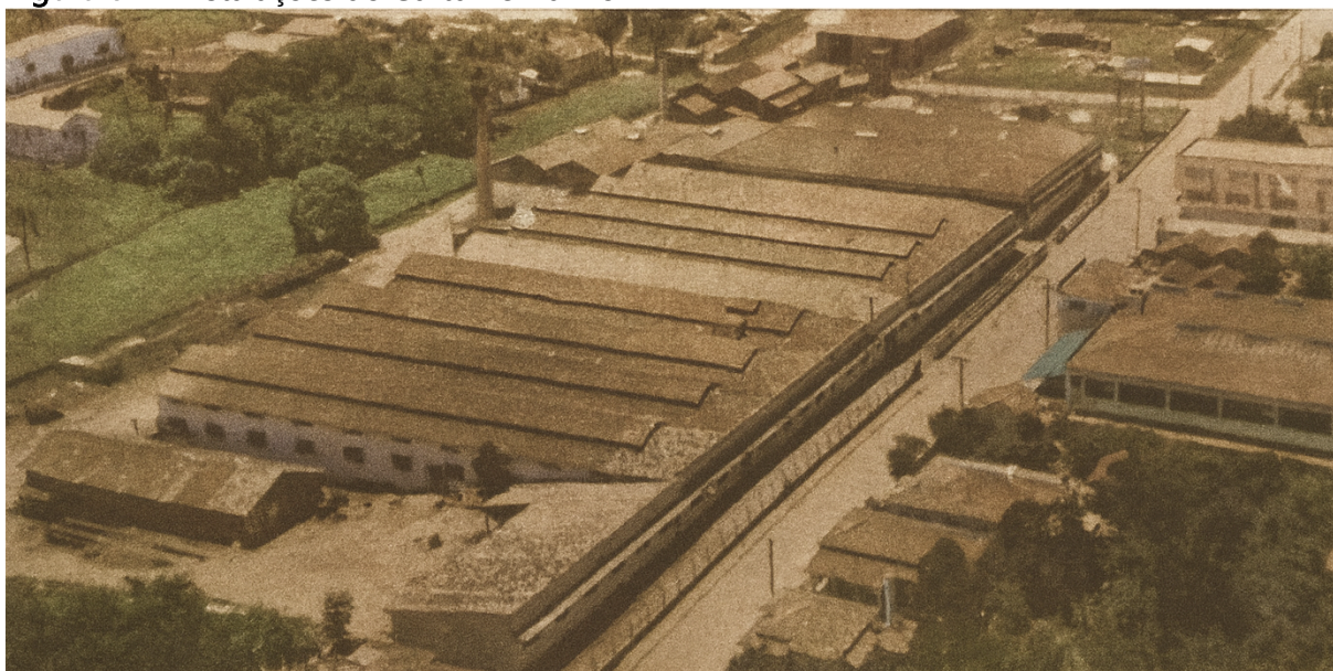
Figura 61 – Instalações do Curtume Dal Bó
