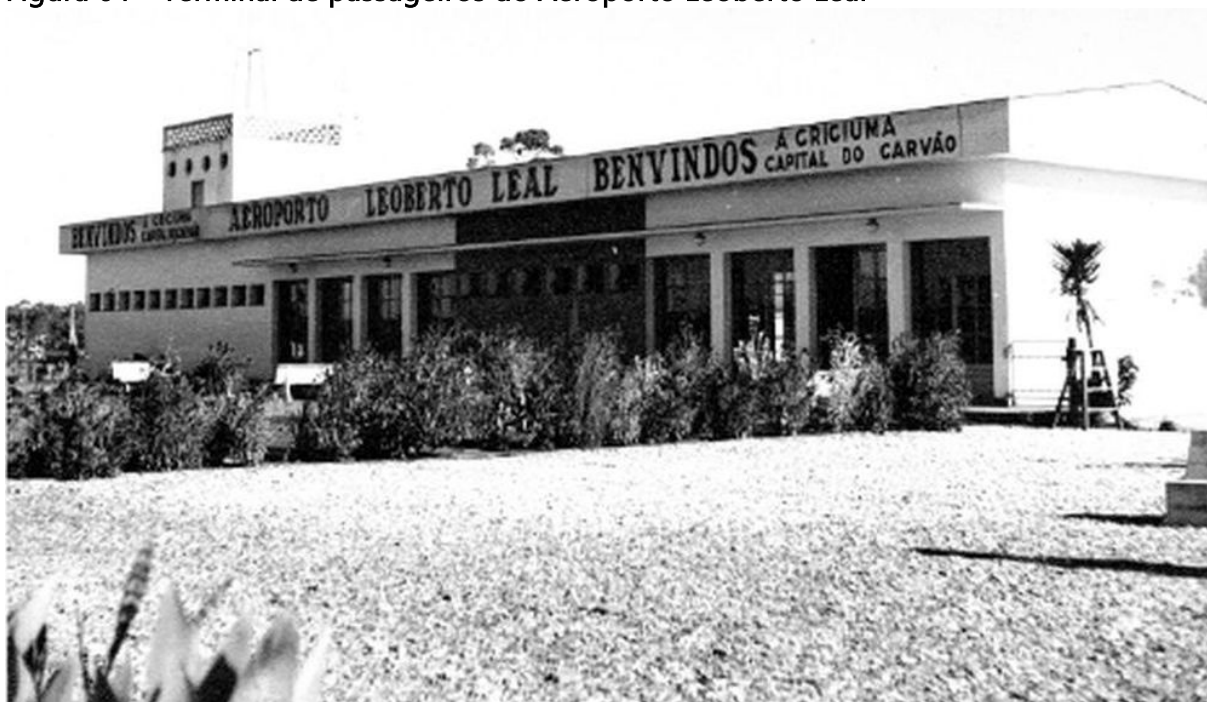
Figura 64 – Terminal de passageiros do Aeroporto Leoberto Leal
