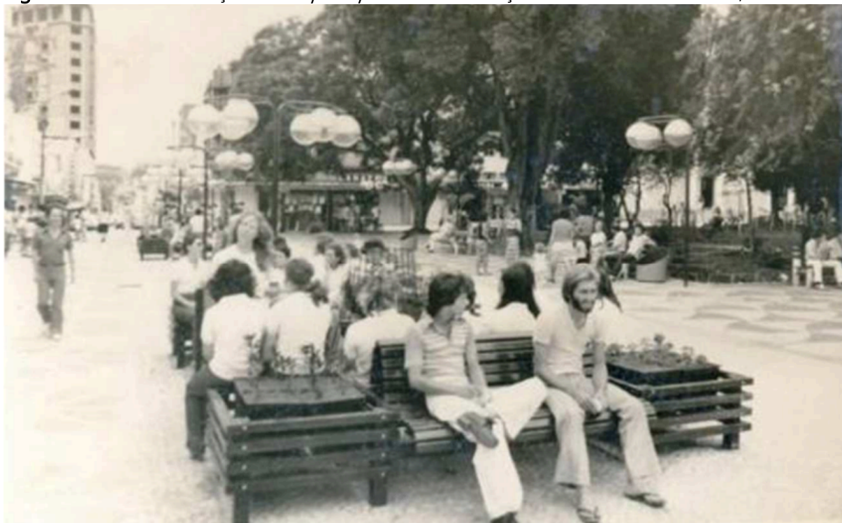
Figura 25 – Vista do calçamento em petit pavet com a Praça Nereu Ramos de fundo, em 1980
