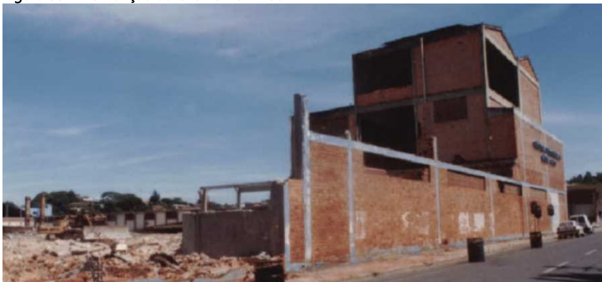
Figura 53 – Demolição da CESACA em 2001
