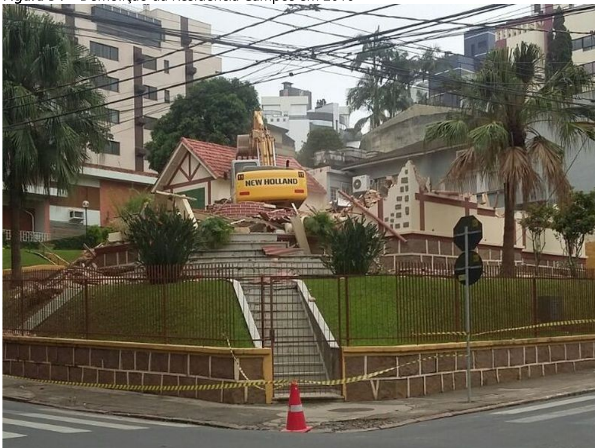
Figura 34 – Demolição da Residência Campos em 2016
