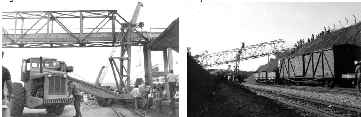
Figura 71 – Retirada do viaduto no centro e instalação no bairro Milanese
