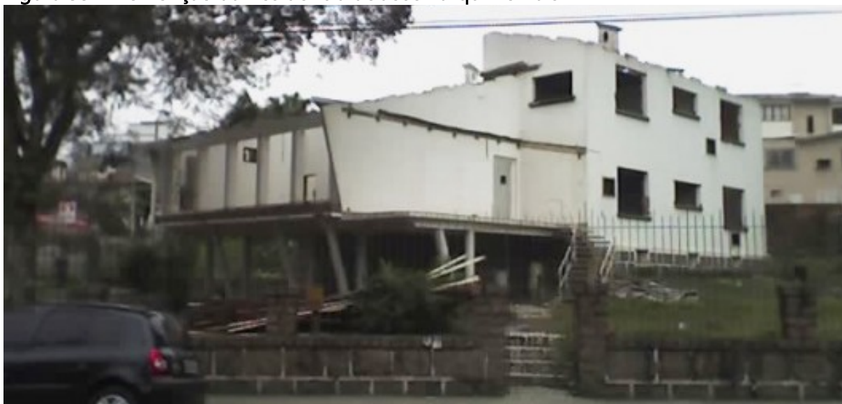
Figura 33 – Demolição da Residência de José Tarquínio Balsini
