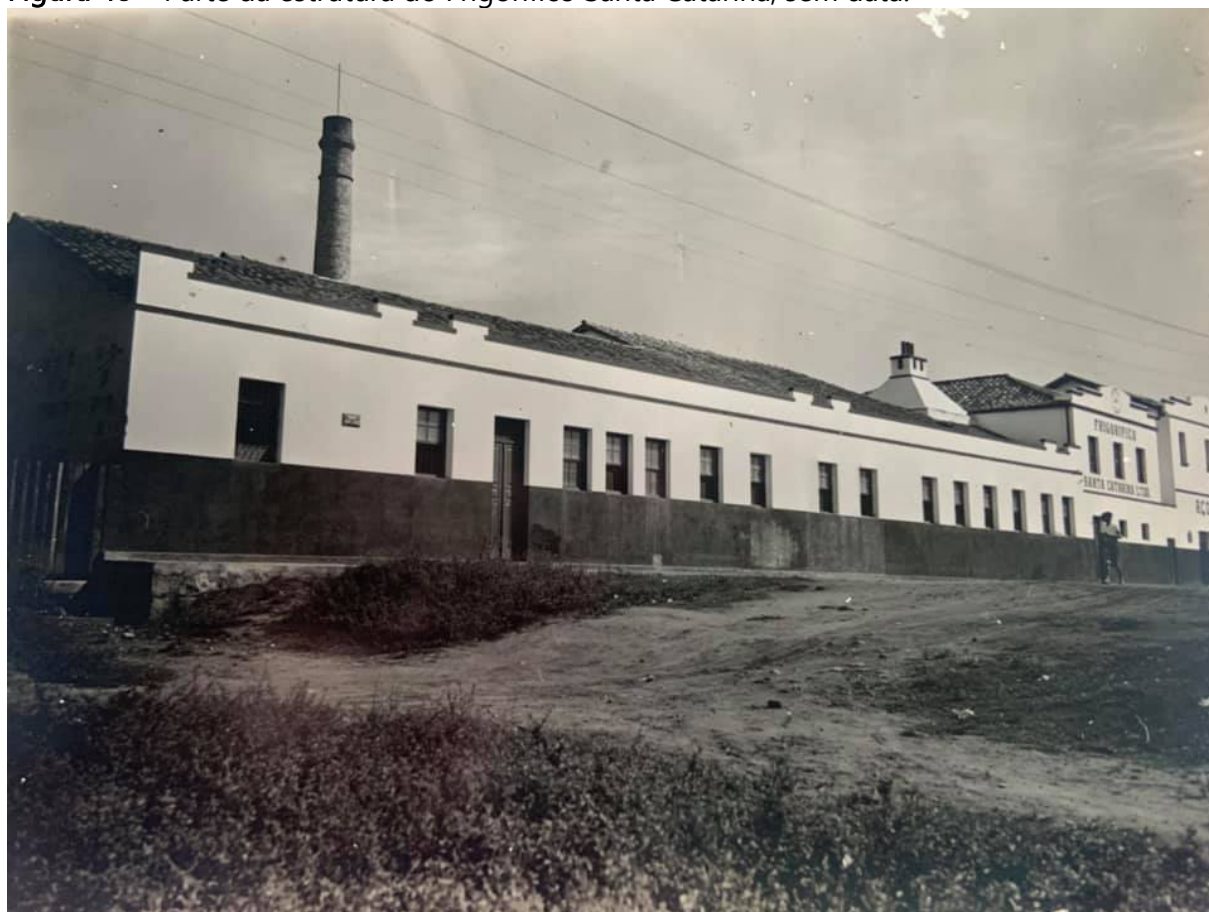
Figura 48 – Parte da estrutura do Frigorífico Santa Catarina, sem data.
