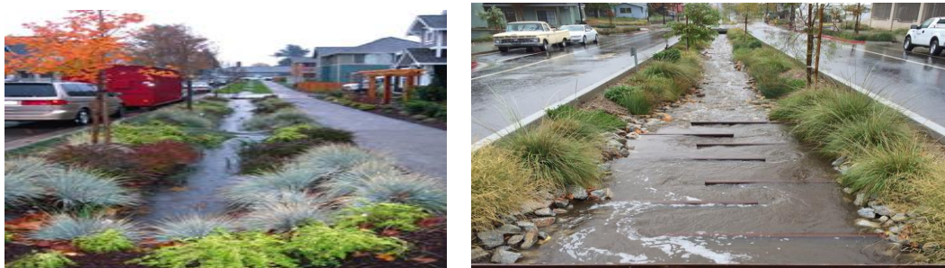
Figura 5.8 - biovaleta em High Point , em Seattle, Washington ; figura 5.9 - Prêmio Inovação Verde, 21st street, Paso Robles, CA .
