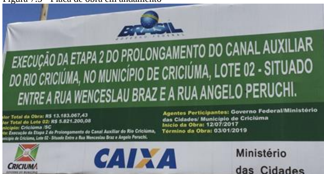
Figura 7.5 - Placa de obra em andamento
