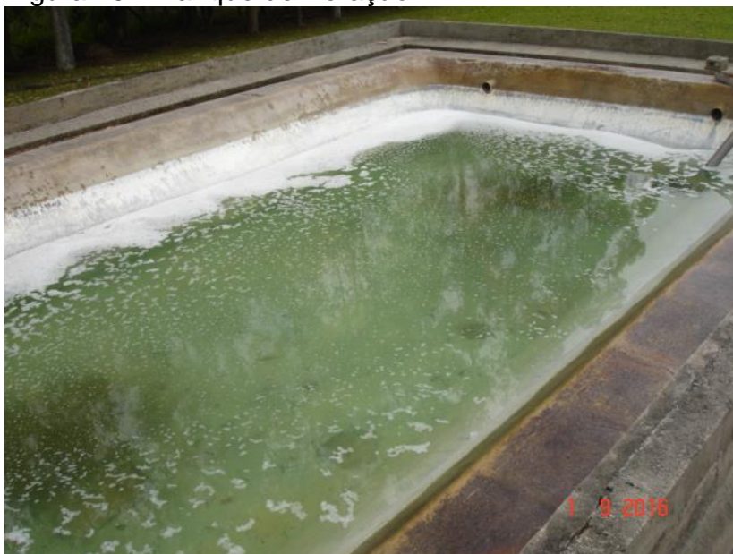
Figura 10 – Tanque de Aeração.
