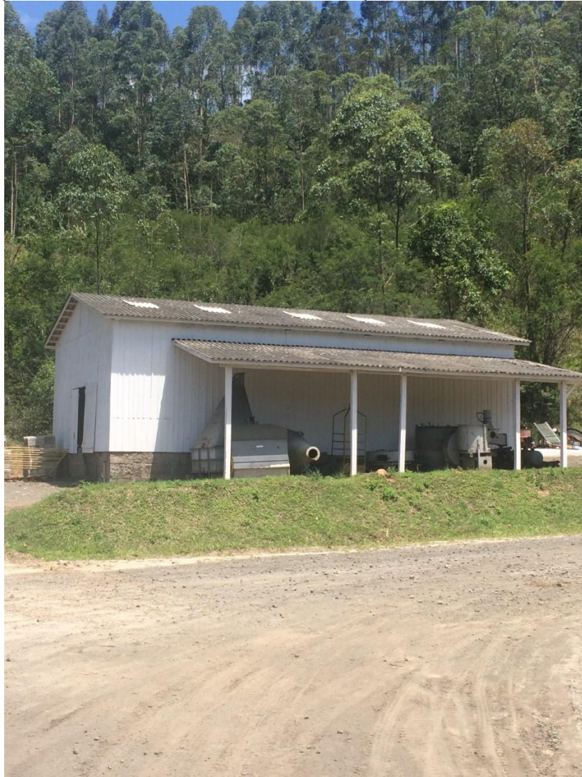
Figura 3 - Depósito Intermediário de Resíduos depois da reforma.
