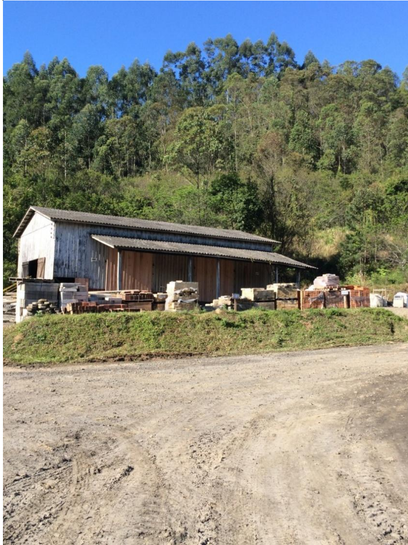
Figura 2 - Depósito Intermediário de Resíduos antes da reforma.
