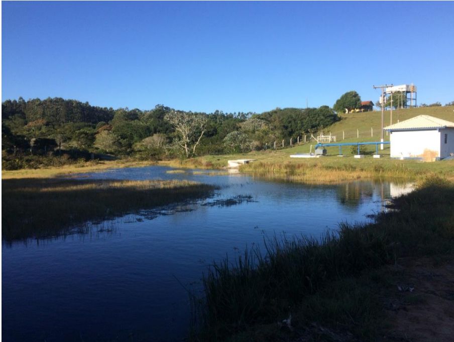
Figura 4 – Reservatório e casa de tratamento
