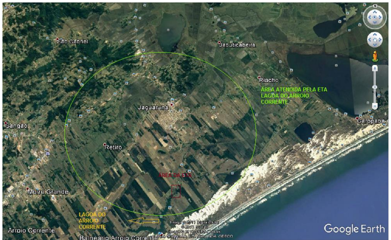
Figura 3 – Localização ETA I - Lagoa do Arroio Corrente.
