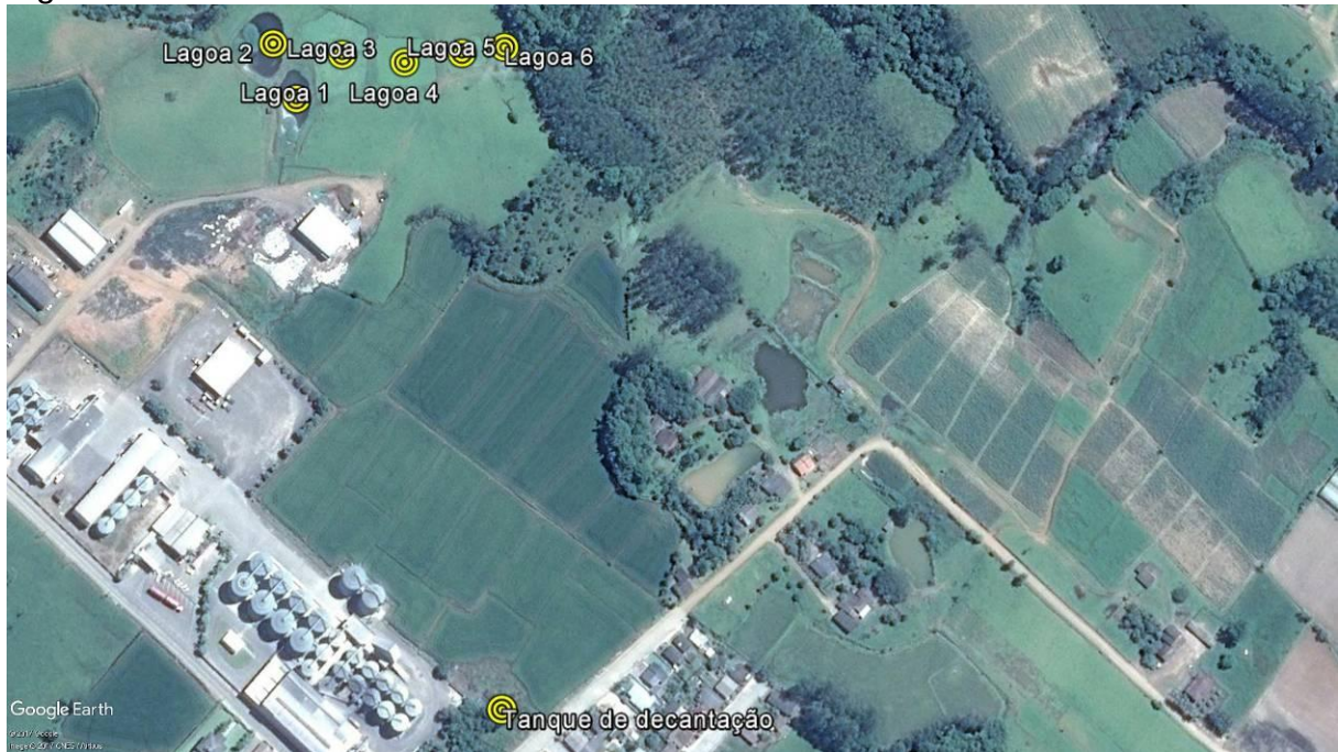
Figura 12: Sistema de tratamento efluente.
