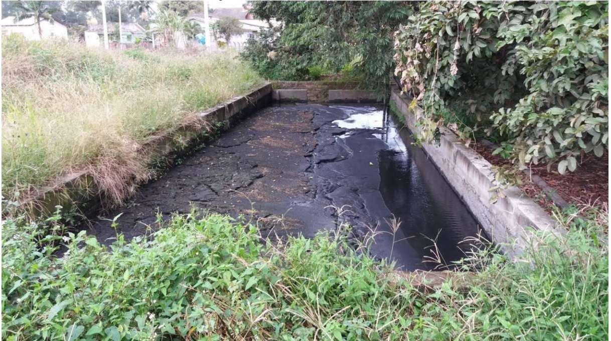
Figura 13: Tanque de decantação de cinzas.
