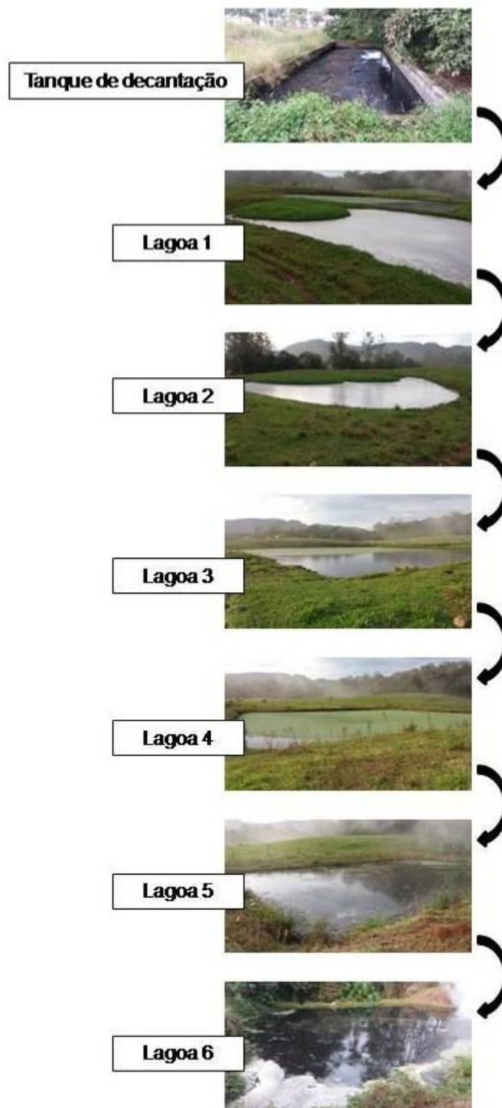
Figura 11: Etapas Estação de Tratamento de Efluentes: Lagoas.
