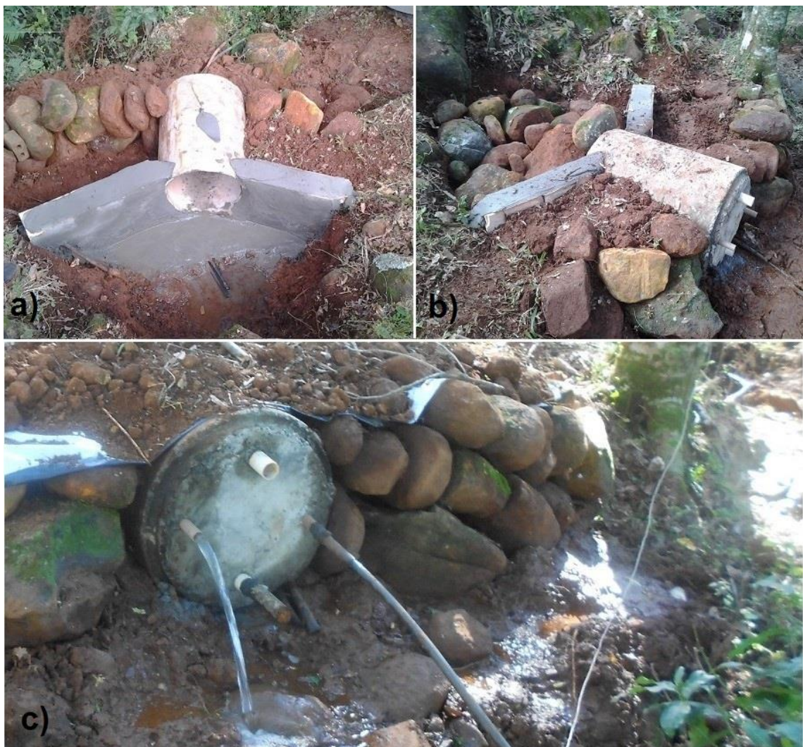
a) Assentamento do tubo de concreto com massa de cimento; b) Proteção da fonte, com barragem e pedras; c) Funcionamento da fonte. Fonte: PMSA, 2014.
