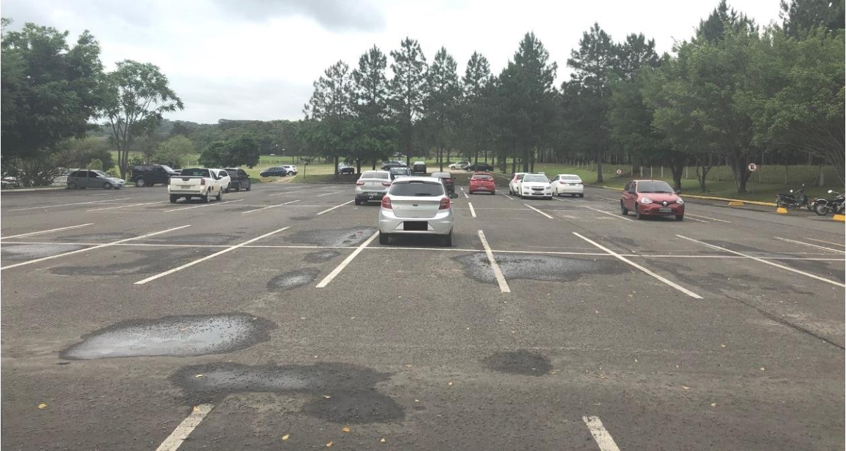
Figura 11 – Local escolhido para instalação do sistema (Estacionamento 01)
