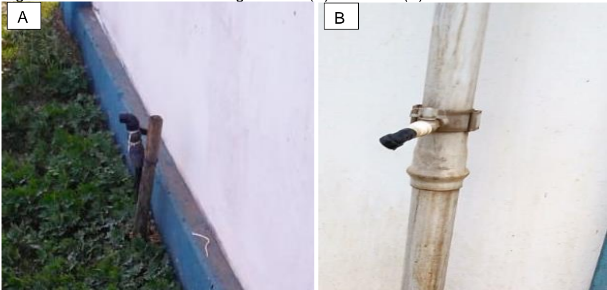
Figura 7 – Pontos de coleta da água bruta (A) e tratada (B) - ETA V.
