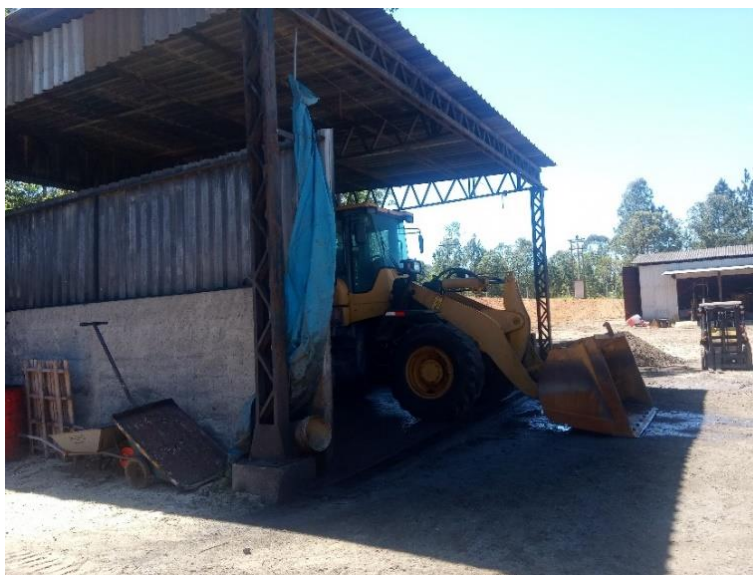
Figura 30 - Necessidade de ampliação do setor de lavação.
