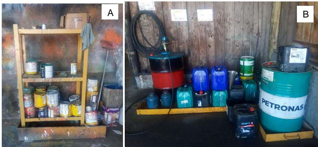
Figura 28 - Bandeja de contenção no setor de pintura (A) e oficina automotiva (B).
