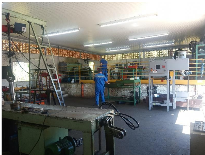
Figura 7 - Setor de oficina hidráulica.
