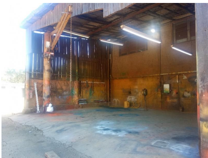
Figura 19 - Setor de pintura.
