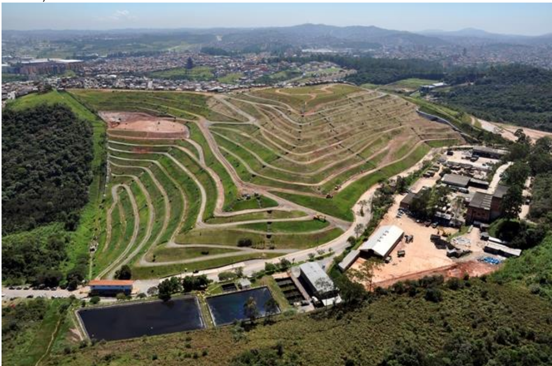
Figura 5 – Vista panorâmica do aterro sanitário municipal (CTR) de Santo André, SP.
