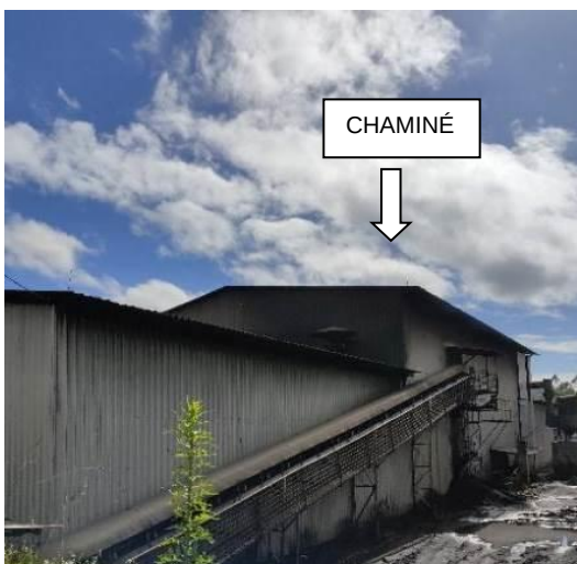
Figura 17: Vista da chaminé durante a queima de derivados de madeira.
