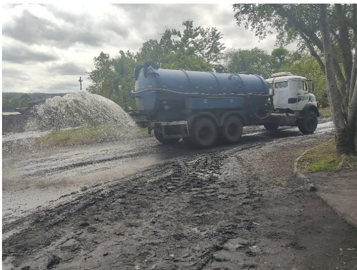
Figura 21: Caminhão pipa da empresa realizando a umidificação.
