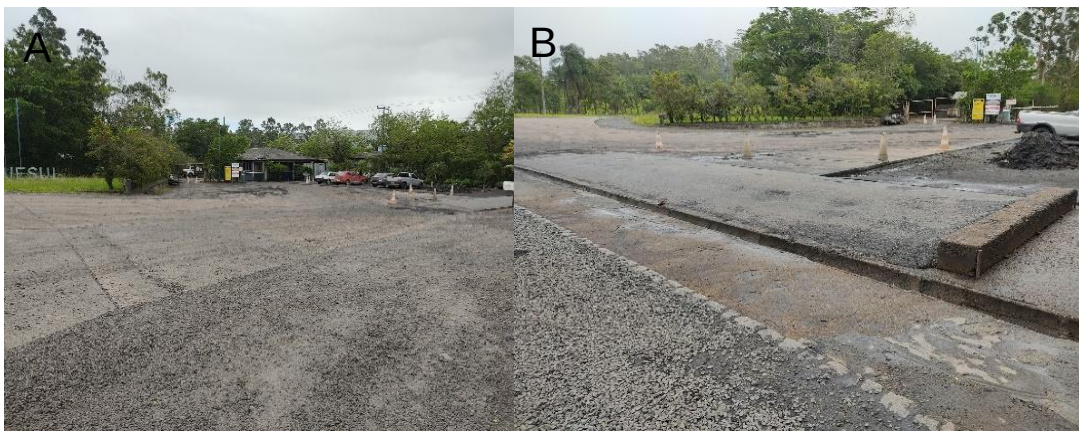
Figura 19: A - Rampa construída de concreto. B - Local da lavação dos veículos.
