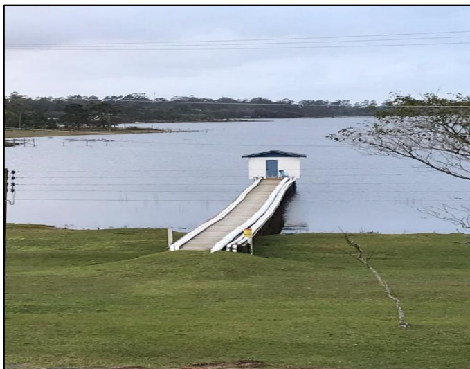
Figura 07- Casa de bomba
