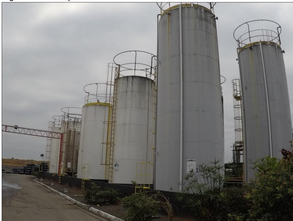
Figura 23 - Tanques de armazenamento
