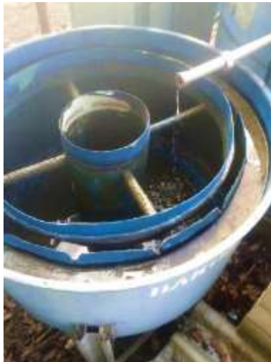
Figura 24 - Decantador secundário antes do reparo
