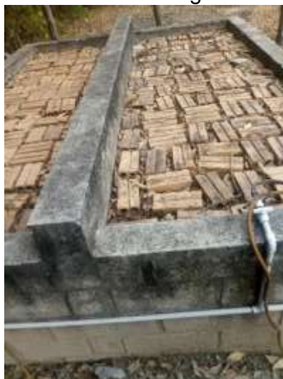
Figura 26 – Leitos de secagem da estação 1
