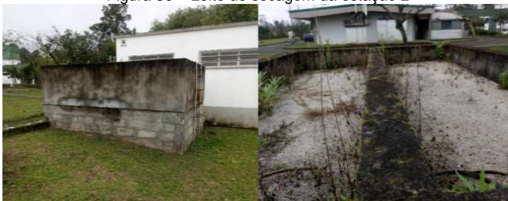
Figura 30 – Leito de secagem da estação 2
