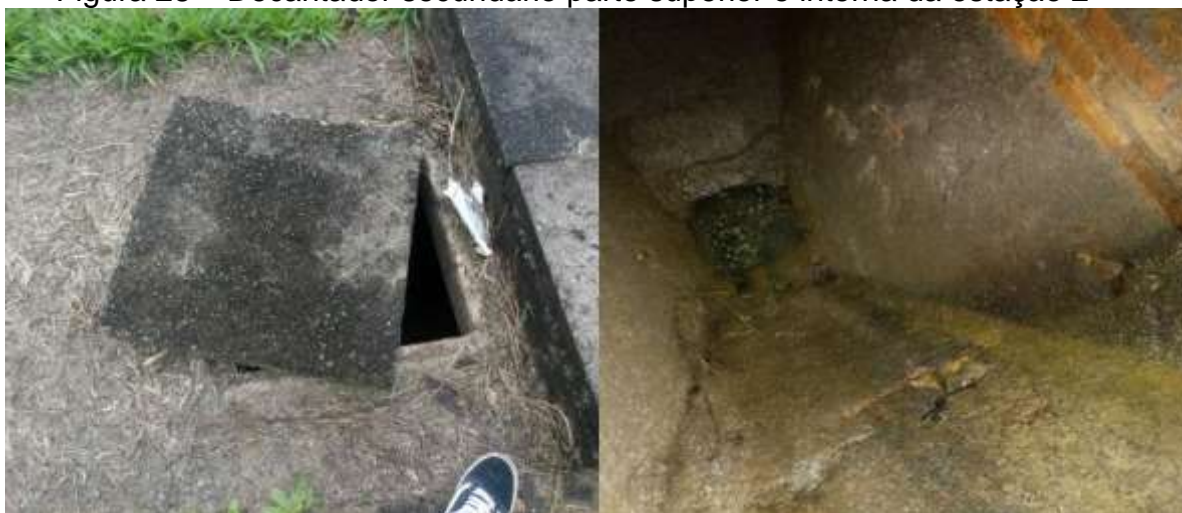
Figura 28 – Decantador secundário parte superior e interna da estação 2
