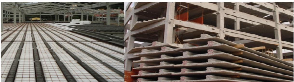
Figura 3 - Pré lajes protendidas no Canteiro de obras.
