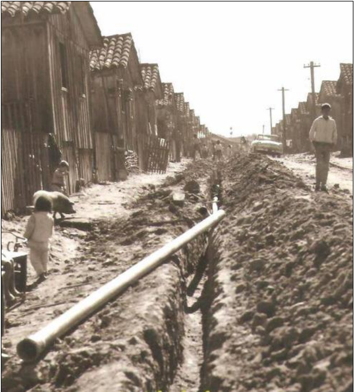
Figura 5 - Vila Operária do Guatá durante a instalação do sistema de abastecimento de água. No canto esquerdo é possível observar crianças circulando descalças junto aos porcos
