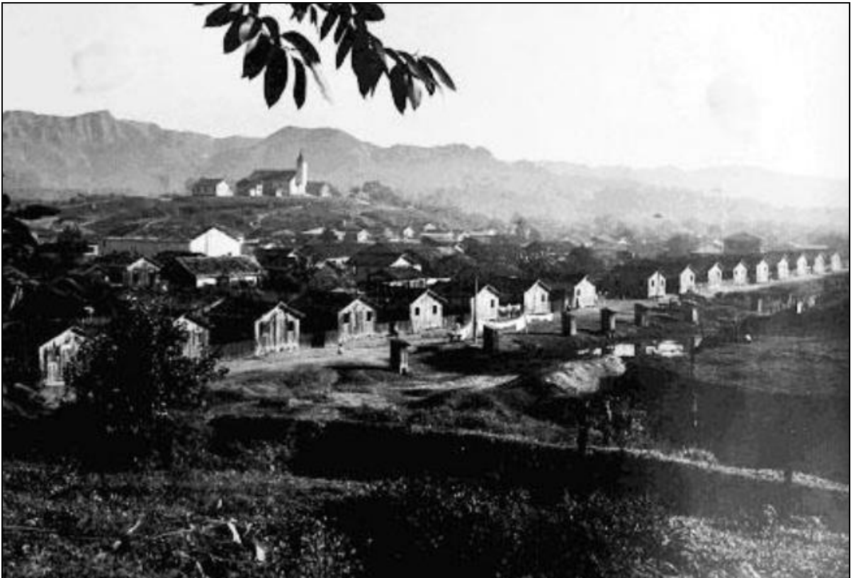
Figura 4 - Foto da Vila Operária do Guatá em que aparecem as patentes localizadas próximas às residências
