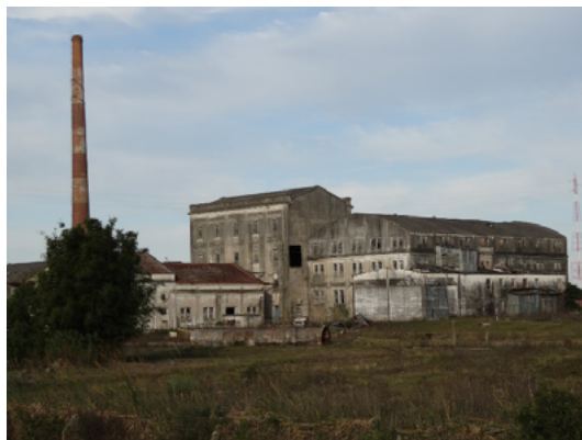
Figura 2 - Prédio onde funcionava o Engenho Pedro Osório
