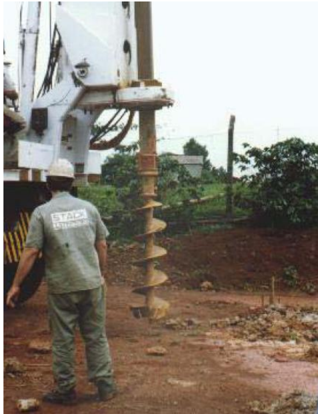
Figura 3 - Detalhe do equipamento de escavação.
