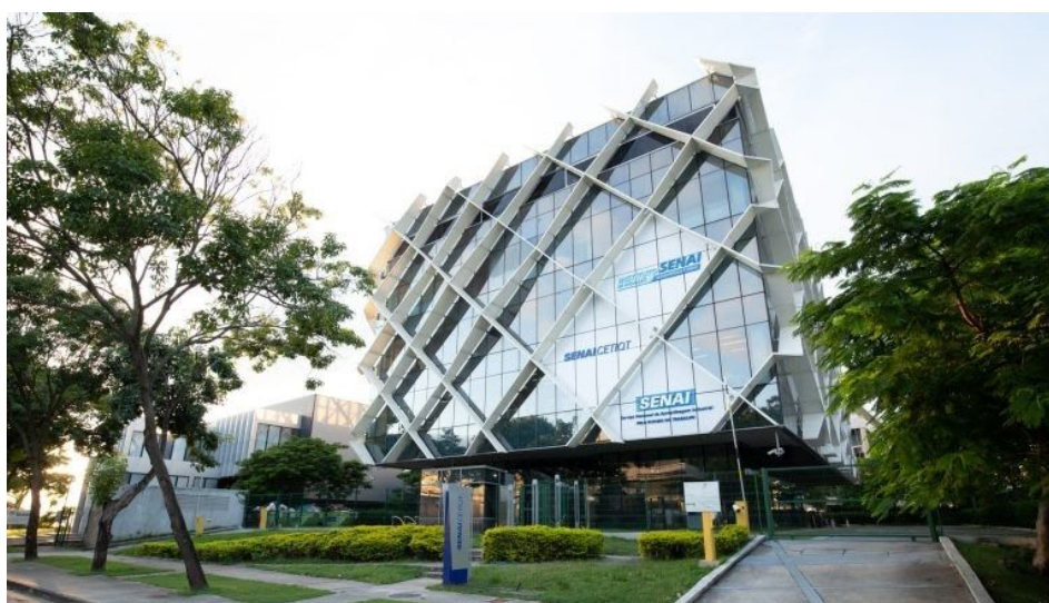
Figura 3- Prédio do ISI.
