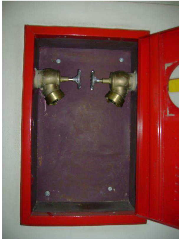
Figura 8 – Hidrante de parede – saída dupla Fonte: Zanin (2008)
