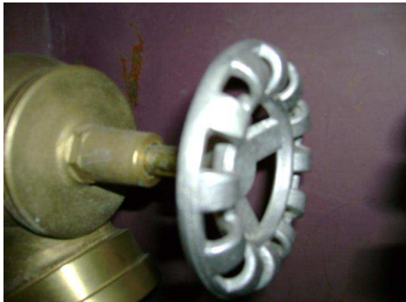
Figura 5 – Hidrante de parede – registro angular Fonte: Zanin (2008)
