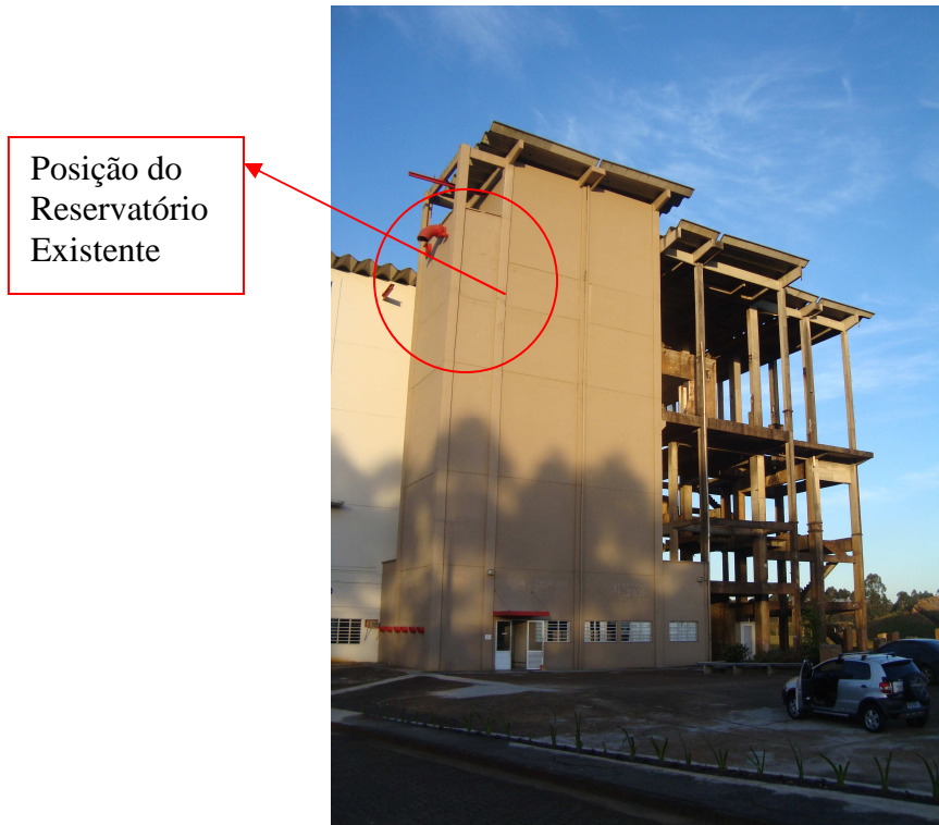
Figura 14: Estrutura de concreto Armado Existente Fonte: Do Autor
