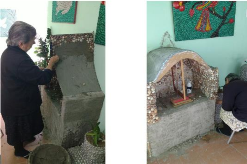
Figura 30 - Primeira e segunda etapas da obra
