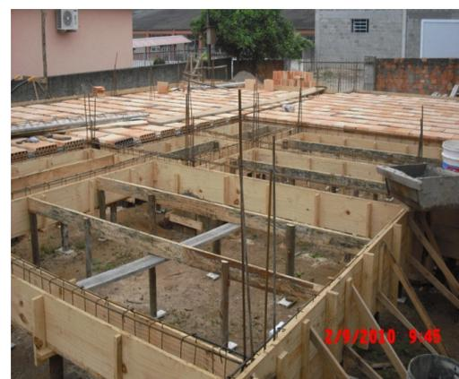
Figura 07 – Execução das vigas
