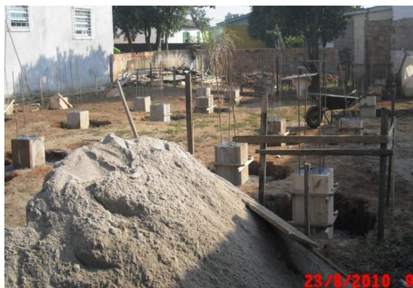
Figura 11 – Execução das fundações e colarinhos
