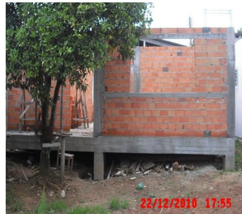
Figura 09 – Execução dos pilares
