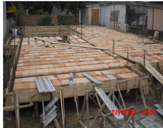
Figura 05 – Execução das lajes de piso
