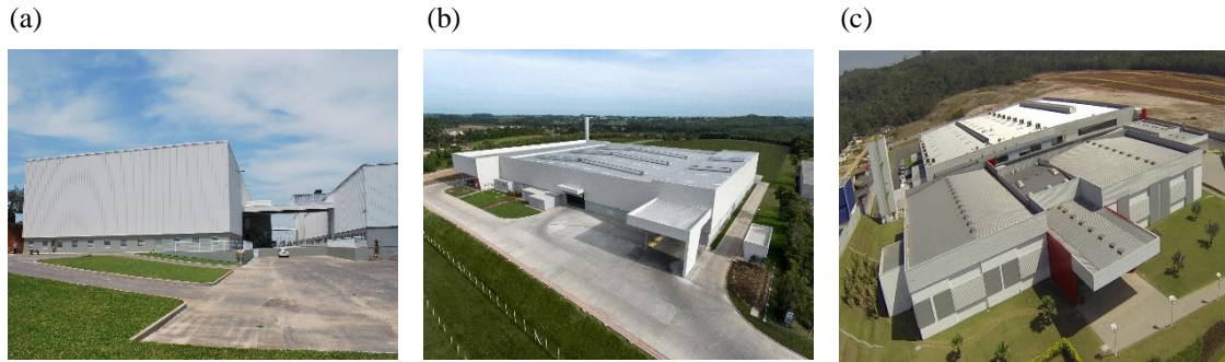
Figura 2. Imagens das obras: (a) obra 1, (b) obra 2, (c) obra 3
