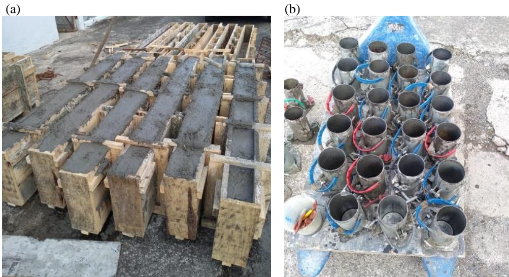
Figura 5: (a) Concretagem das vigas; (b) Moldes de corpo de prova
