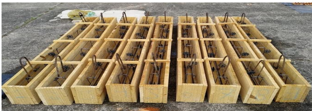
Figura 3. Vigas prontas para concretagem
