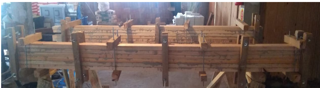
Figura 5. Prensagem da viga de MLC.
