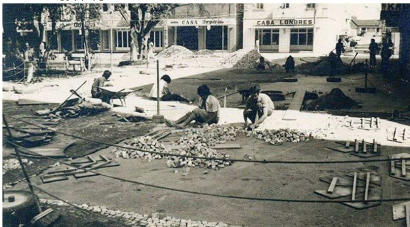
Figura 55 – Colocação do petit pavet em frente à Catedral São José, em 1977-78
