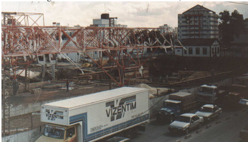
Figura 51 – Construção do Terminal Central, ao fundo, a Casa do Agente Ferroviário antes de ser demolida, em 1995.
