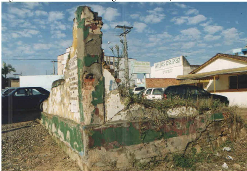
Figura 53 – Ruínas da Casa do Agente Ferroviário, em abril de 2001
