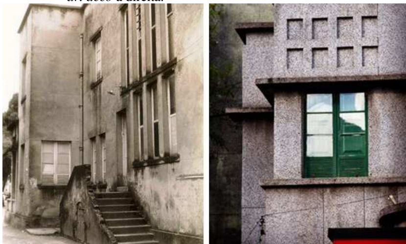
Figura 39 – Detalhe da entrada lateral do edifício, à esquerda e da organização das portas e janelas que denotam características art déco à direita.
