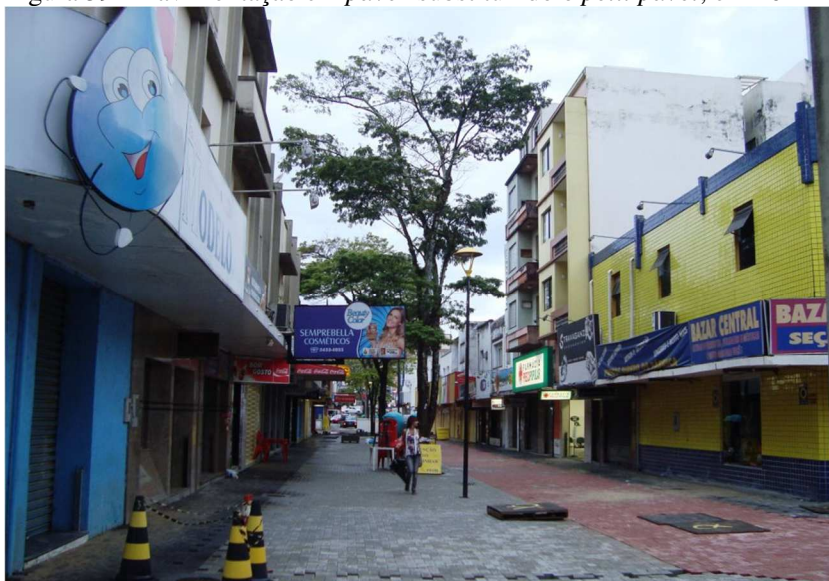
Figura 59 – Pavimentação em paver substituindo o petit pavet , em 2012
