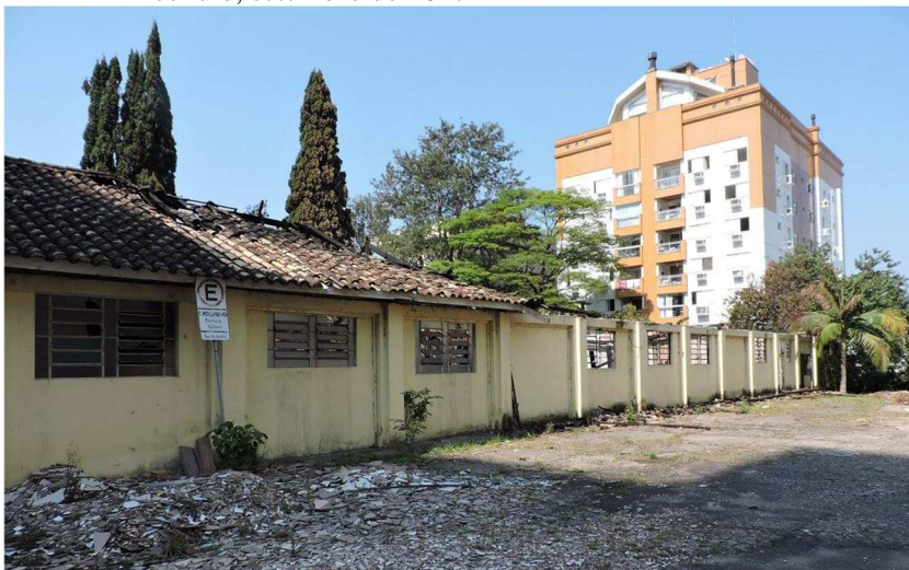
Figura 65 – Galpão Arte do Centro Cultural Jorge Zanatta após o incêndio, setembro de 2017
