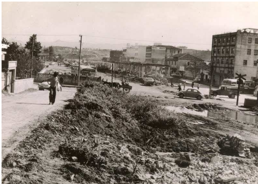
Figura 20 – Retirada dos trilhos para a implantação da Avenida Axial, década de 1970
