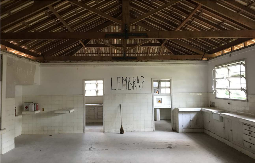
Figura 72 – Galeria de Arte do Centro Cultural Jorge Zanatta durante o restauro, em 2018
