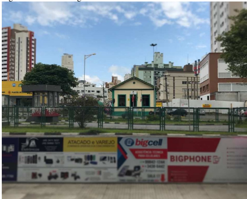
Figura 27 – Casa do Agente Ferroviário reconstruída
