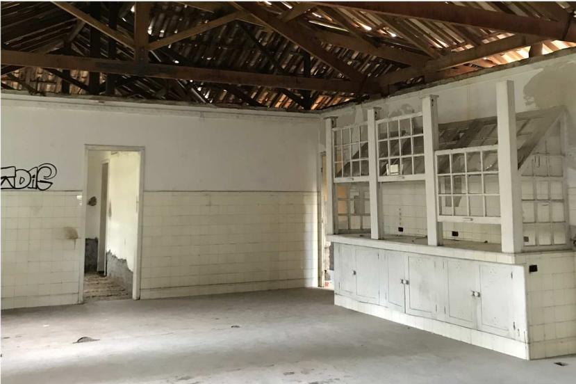
Figura 73 – Galeria de Arte do Centro Cultural Jorge Zanatta durante o restauro, em 2018
