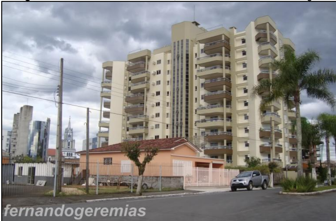
Figura 12: Condomínio Residencial, localizado na rua Getulio Vargas
