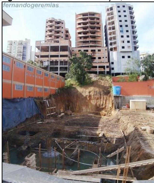
Figura 11: Edifícios em construção, em 2009.
