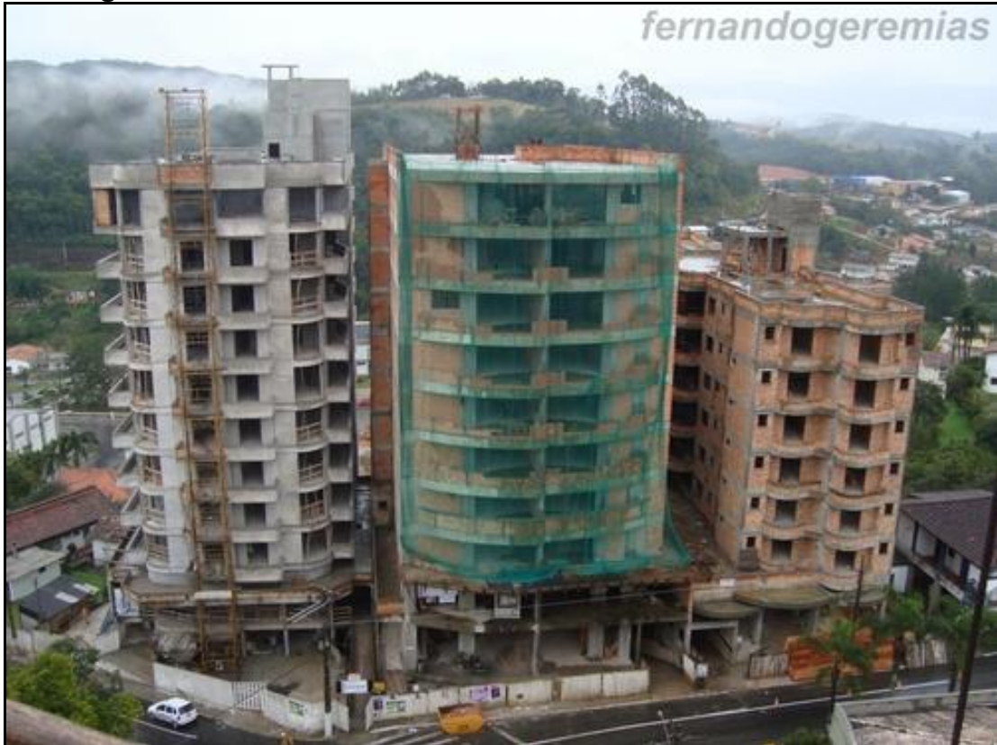
Figura 9: Edifícios “Robustos” na rua XV de Novembro atualmente
