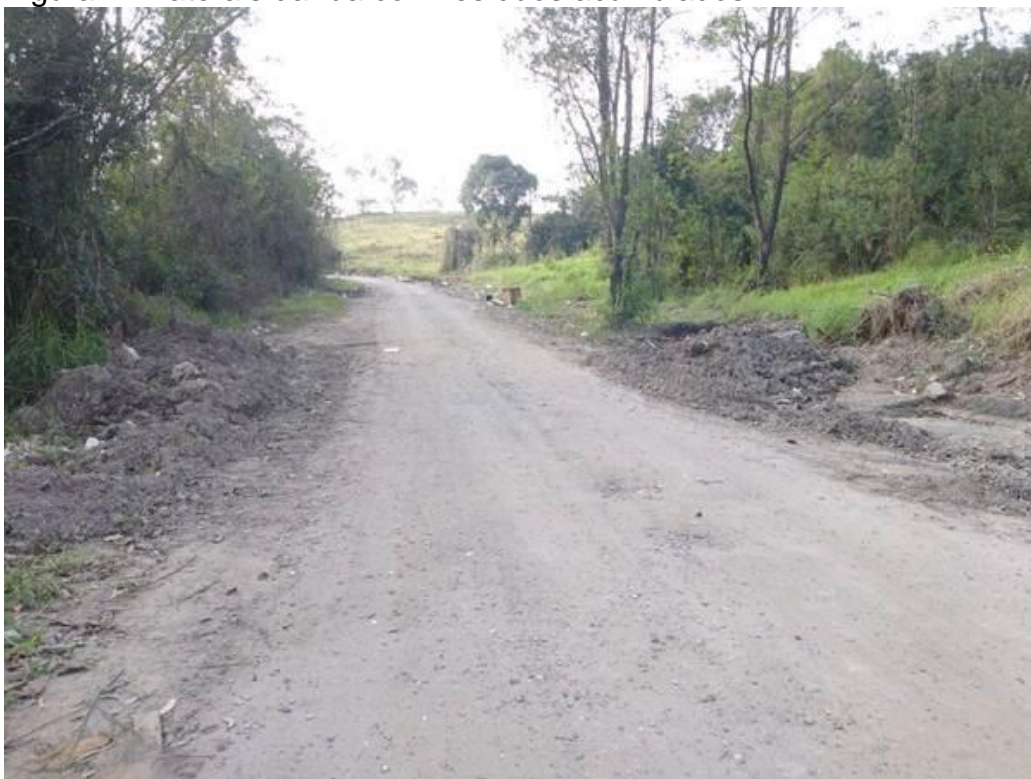
Figura 7 - Laterais da rua com resíduos acumulados
