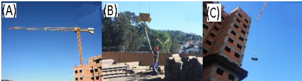
Figura 4 - (A) Grua; (B) Amarração do material; (C) Movimentação de material
