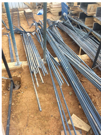
Figura 10: Armazenamento das barras
