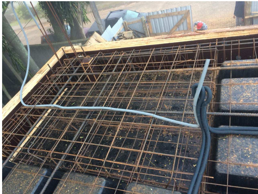
Figura 05: Armadura dos capitéis do 1º tipo
