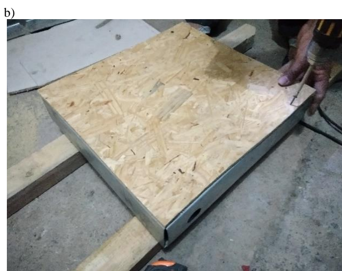
Figura 2. Projeto base dos painéis. a) Projeto dos painéis com fechamento em placa de OSB. b) Execução dos painéis com fechamento externo em placa de OSB.
