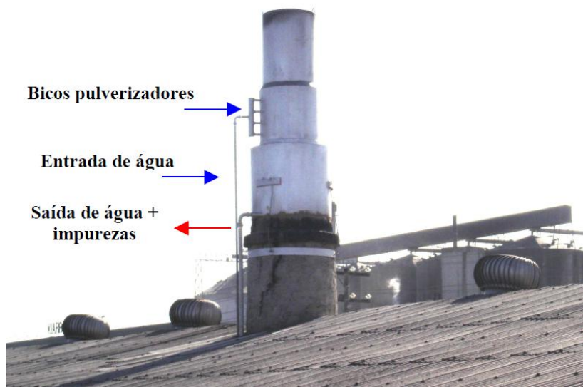
Figura 10 - Vista do lavador de gases, instalado no prolongamento da chaminé em cerâmica vermelha em Morro da Fumaça/SC
