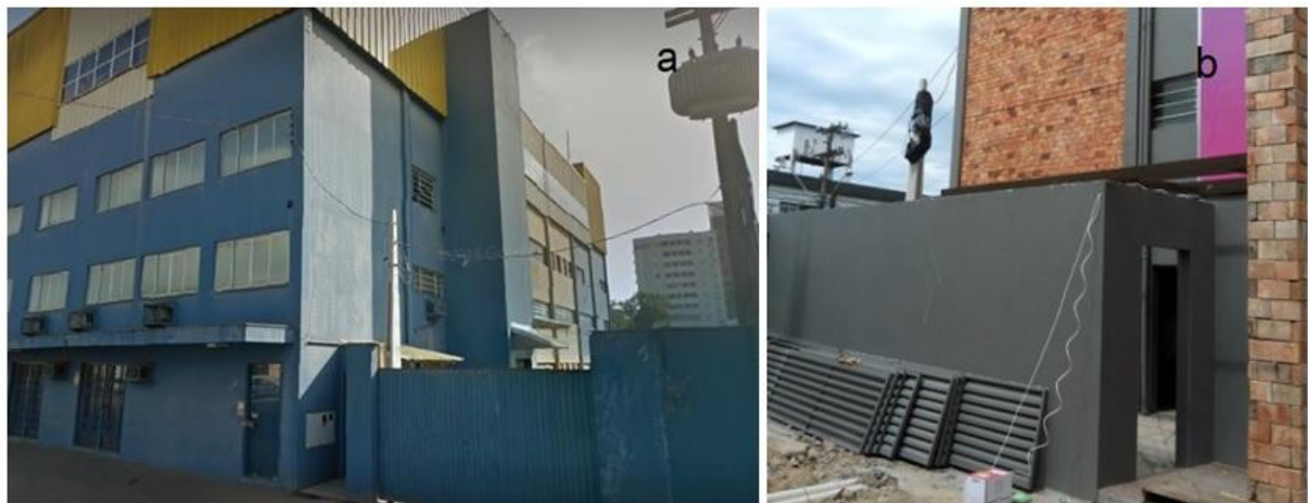
Figura 13- Mudança na entrada principal da fachada sul.
