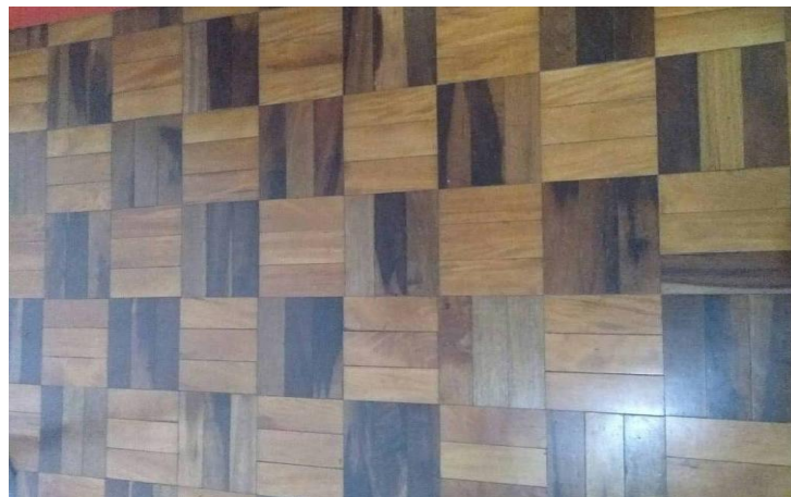
Figura 10- Piso de parquet de madeira.
