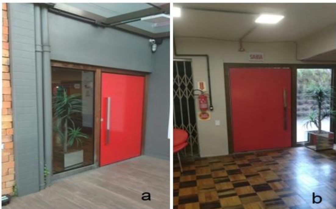
Figura 18 – Porta de Entrada Principal de ACM.
