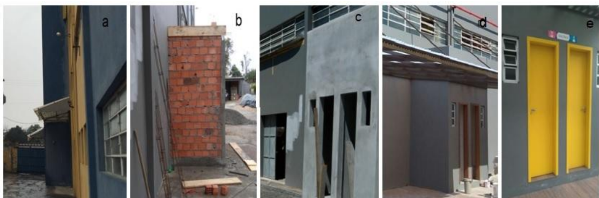
Figura 12- Parede de vedação do novo banheiro.
