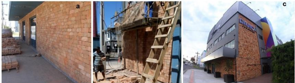
Figura 14 – Revestimento da Fachada de tijoletas.
