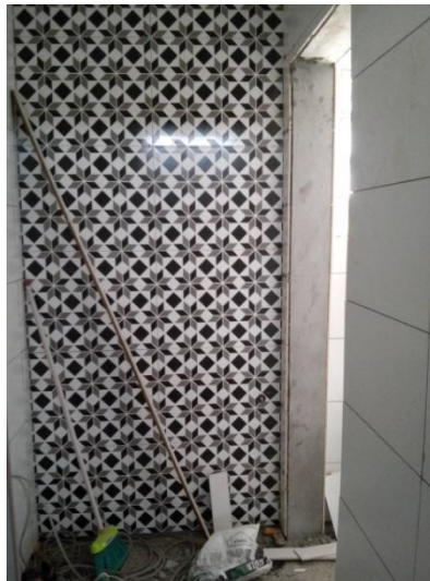
Figura 16- Revestimentos Cerâmicos dos banheiros.
