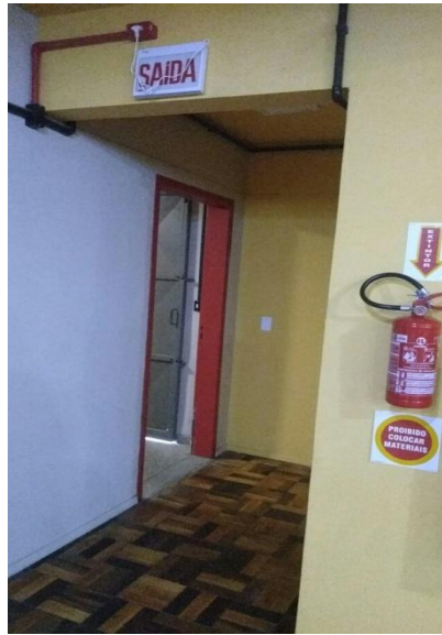
Figura 23- Sinalizações e saída de emergência
