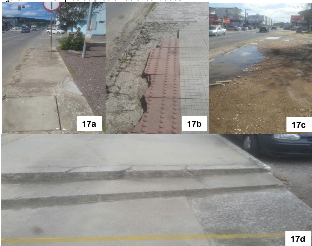
Figura 17 – Exemplos de problemas encontrados.
