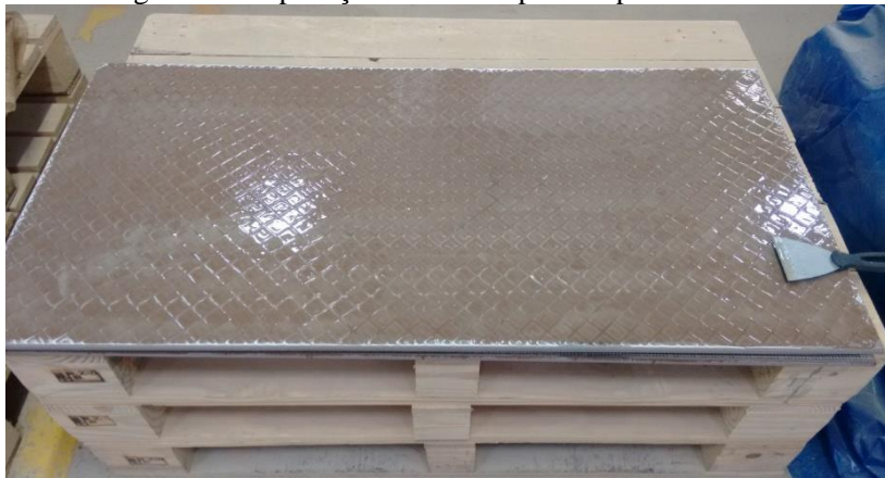
Figura 23 – Aplicação da resina epóxi na placa cerâmica.
