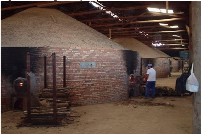
Figura 04- Forno garrafão para queima das telhas.
