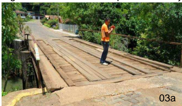
Figura 03: Local antes e após a construção da ponte.
