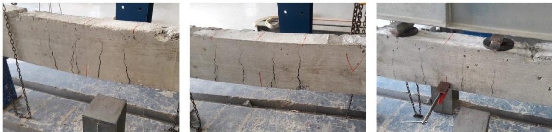
Figura 11 - Fissuras Vigas Maciças com S a cada 16 cm
