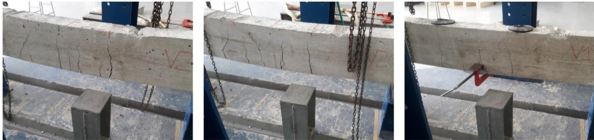
Figura 14 - Fissuras Vigas Ocas com S a cada 16 cm
