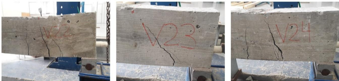
Figura 15 - Fissuras Vigas Ocas com S a cada 16 cm
