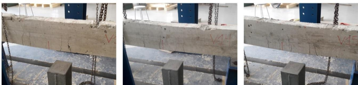
Figura 13 - Fissuras Vigas Ocas com S a cada 10 cm
