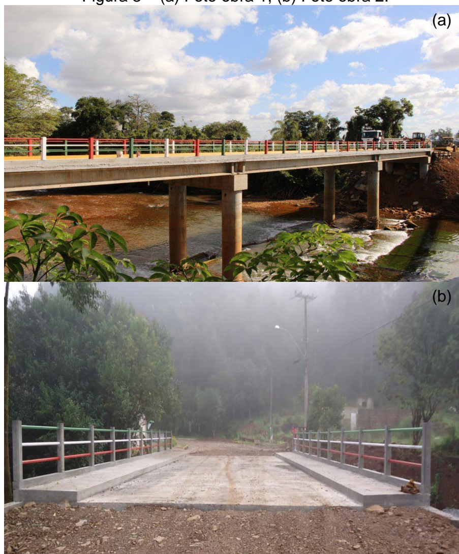
Figura 3 – (a) Foto obra 1; (b) Foto obra 2.
