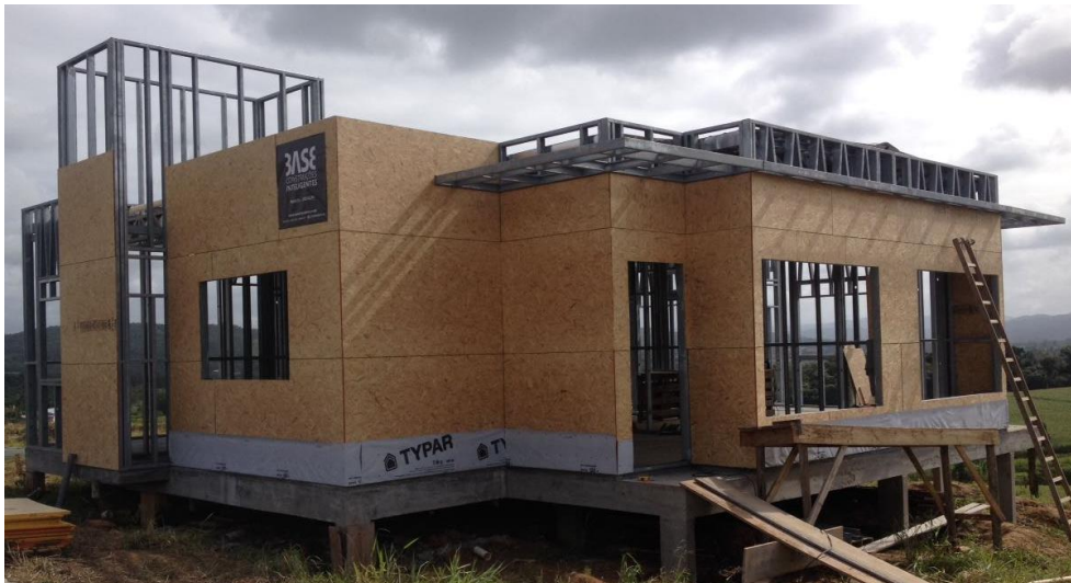
Figura 13 – Obra em execução etapa planos verticais
