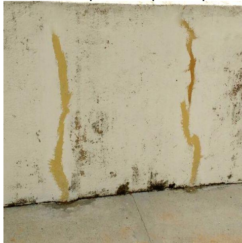
Figura 14 – Materiais aplicados para reparo das fissuras
