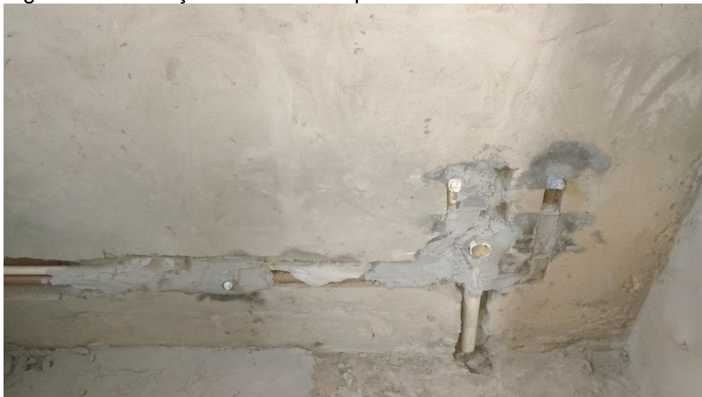
Figura 7 - Tubulação hidráulica na parede realizada antes do reboco
