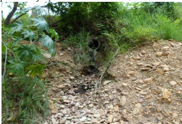
Figura 6 - Esgoto clandestino com caída no leito do rio Urussanga, próximo a junção dos rio Maior e rio Carvão.
